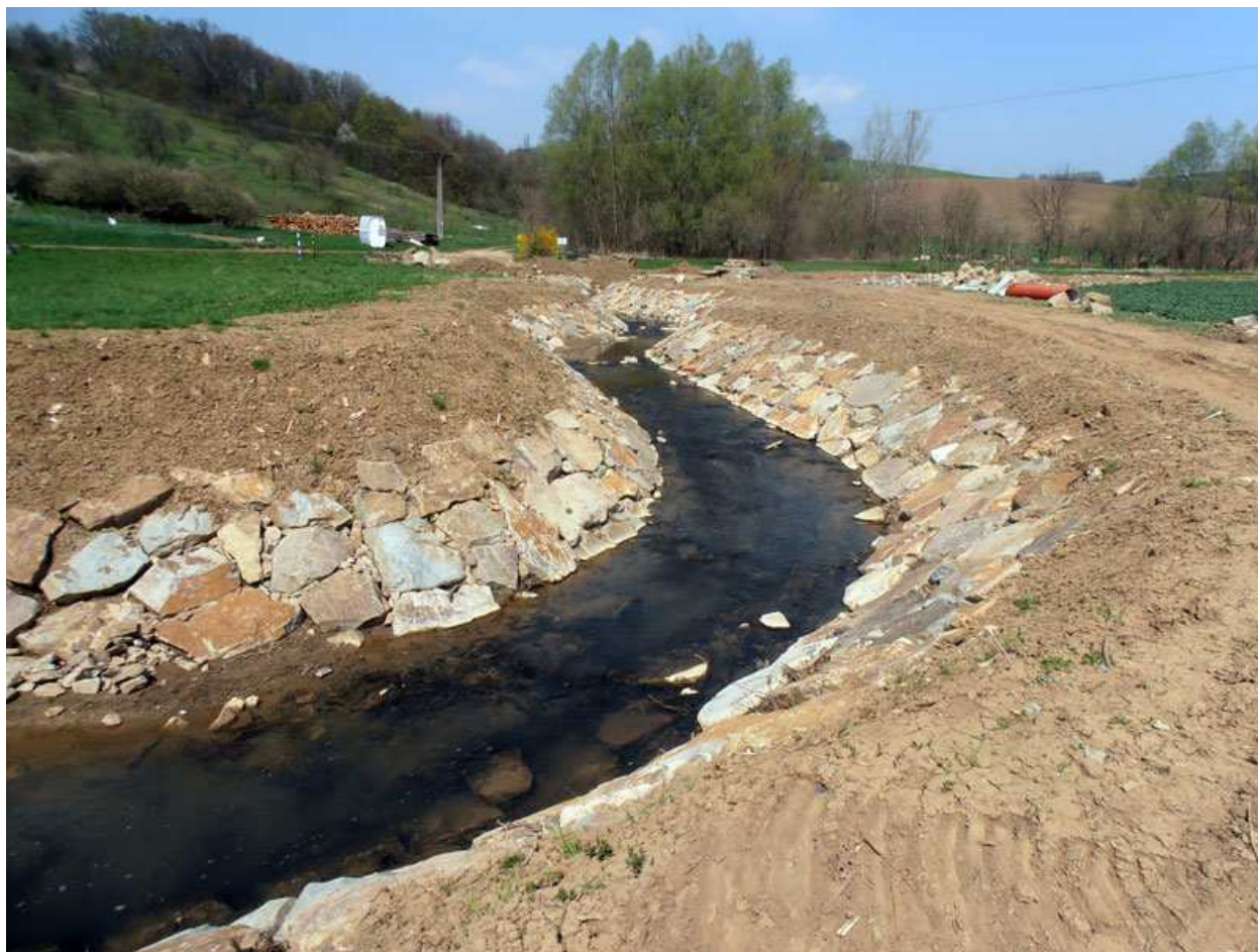
Vzorová ukázka kamenné rovnaniny s vyklínováním
